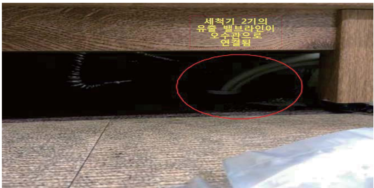
검사 장비 세척기(폐수배출시설)에서 발생된 폐수가 하수(오수)관으로 배출되도록 건물 내 하수(오수)관에 연결
